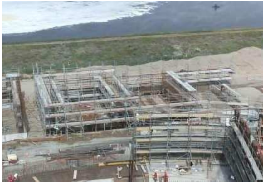
Sala Eléctrica #18 y Edificio Sopladores
