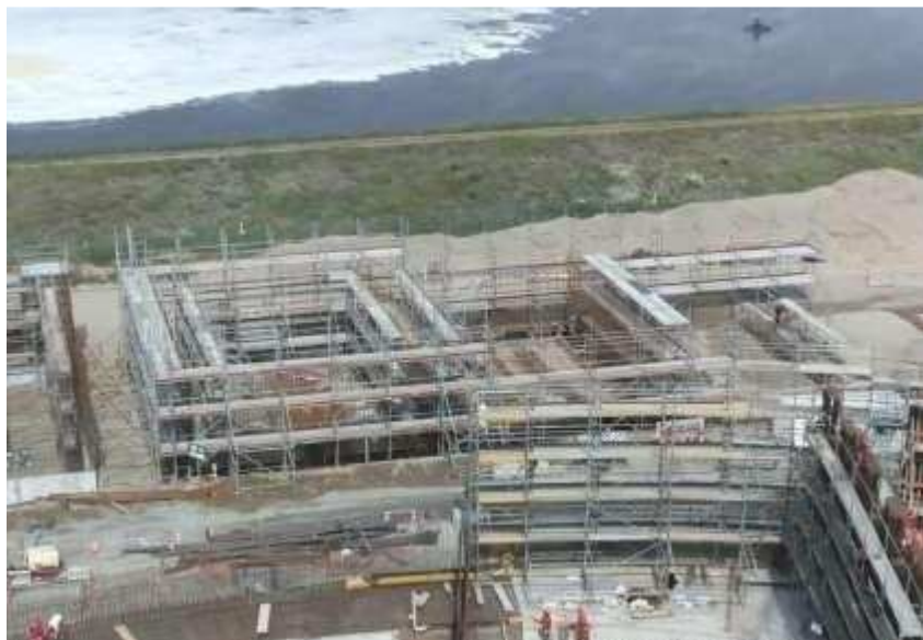
Sala Eléctrica #18 y Edificio Sopladores
