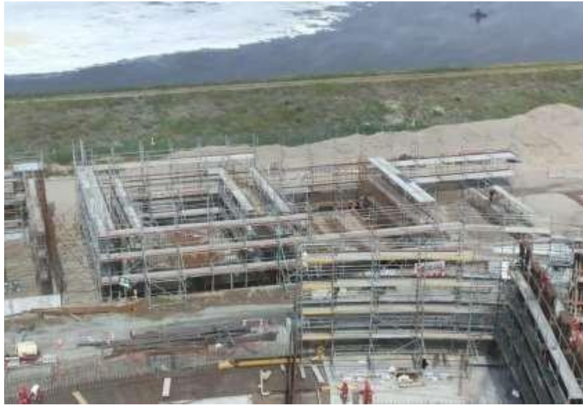
Sala Eléctrica #18 y Edificio Sopladores
